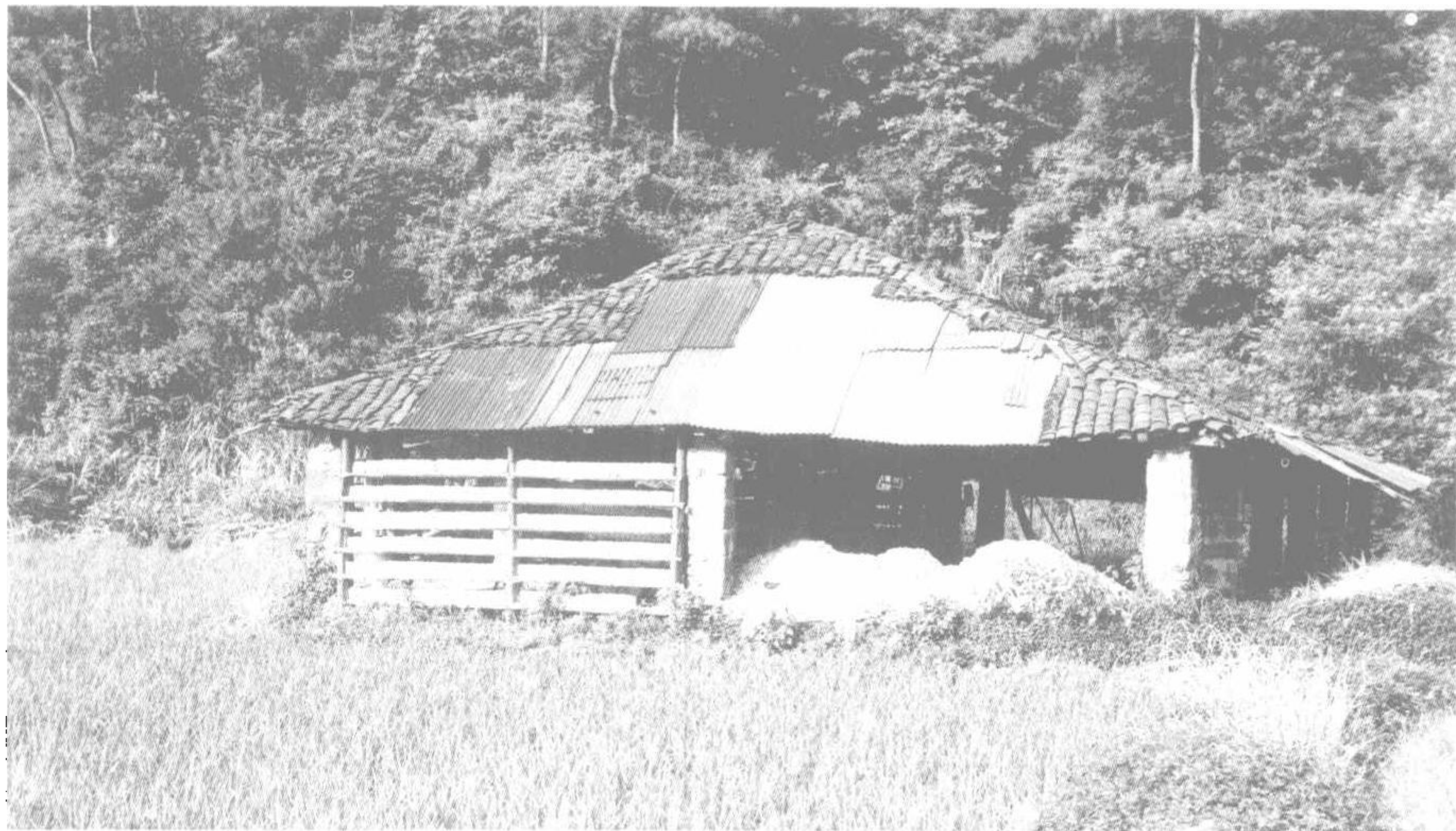
杨梅亭水碓坊建筑外形
